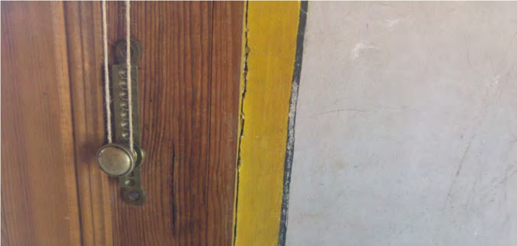
Şekil 28. Stor Perde Mekanizması
